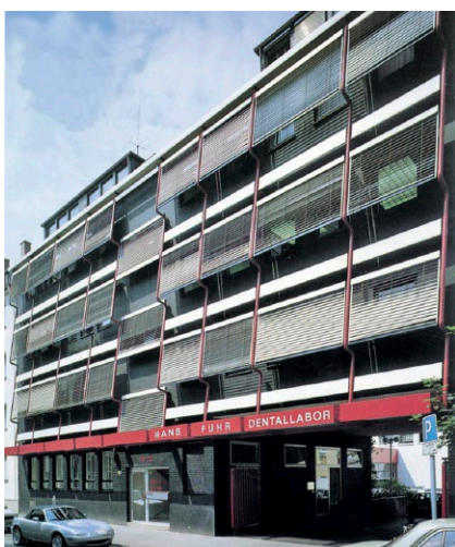
So sieht das Geschäftshaus in der Rubensstraße heute aus
